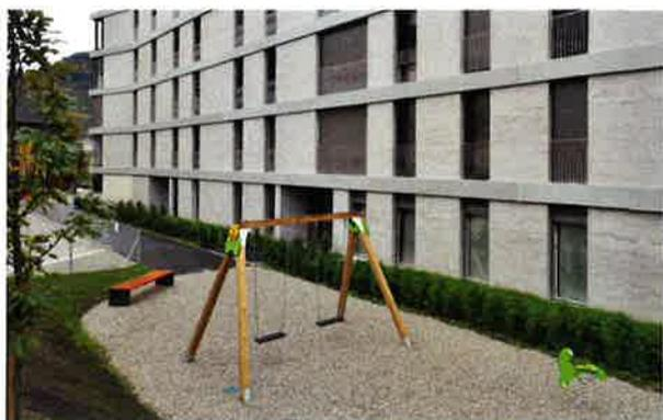
**RÉALISATION** > La structure du bâtiment est en béton armé. Sur les façades se déploient des bandeaux horizontaux en béton fibré marquant les étages et donnant du rythme à la façade extérieure. Entre ces têtes de dalle, un revêtement réalisé en briquettes céramique vient habiller le bâtiment. La teinte gris-beige des briquettes et le gris chaud des bandeaux donnent à l'ensemble un ton sobre et élégant qui cherche à se fondre dans le quartier tout en se démarquant par son caractère singulier.
